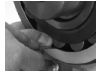
Рис. 15. В процессе монтажа производится проверка РВЗ под ненагруженным роликом.
